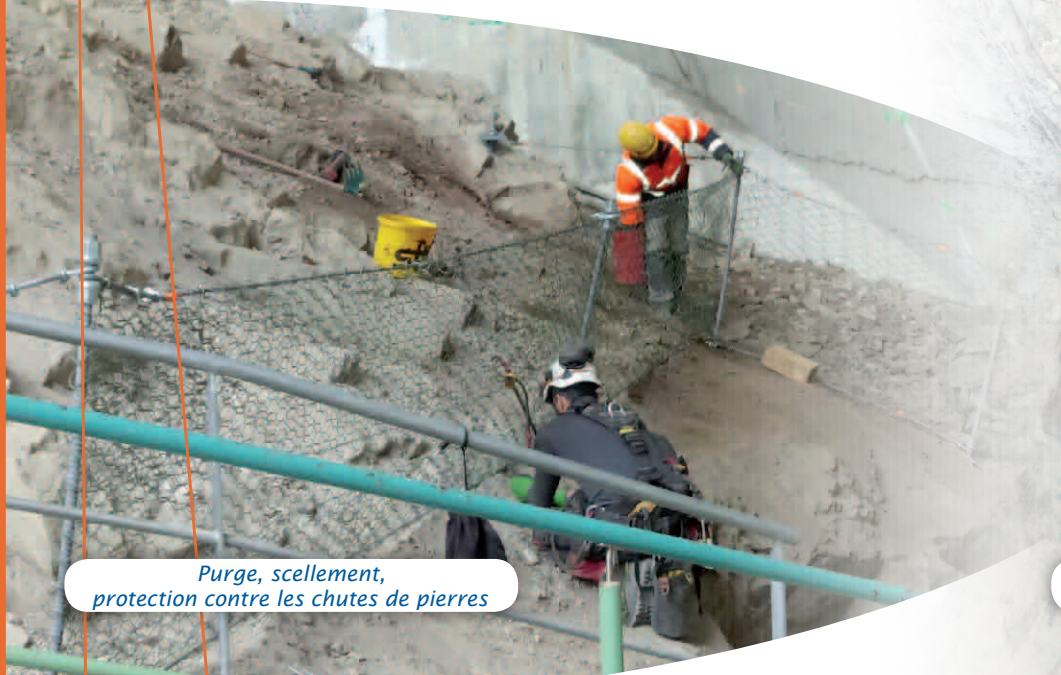
Débroussaillage, abattage, purge, stabilisation de paroi
