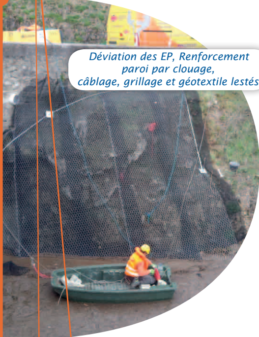
Écoulement gravitaire cloué et maçonné...
